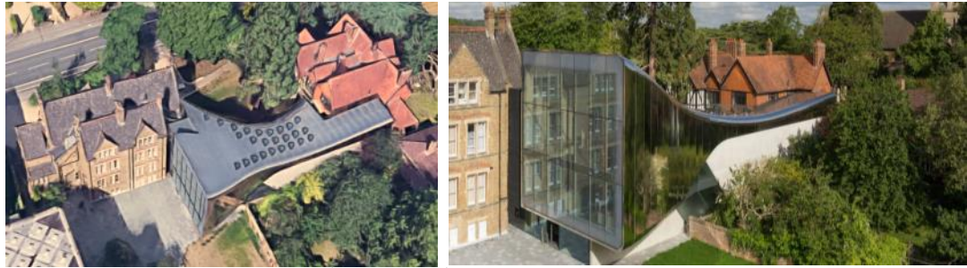
شكل (٥٥، ٥٦) مشروع The Investcorp Building بكلية سان أطوني بجامعة أكسفورد في بريطانيا، من تصميم زها حديد المصدر: (Zaha Hadid Architects, 2015)
